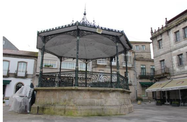
Vista de la fachada oeste en la que se aprecia la incorporación de un altavoz en el alero (se propone su desmontaje).
