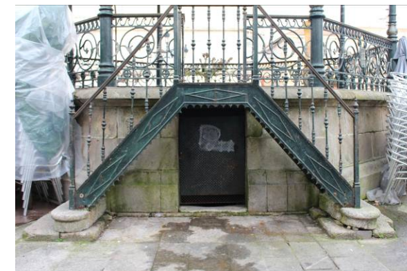
Escalera metálica de acceso al palco
