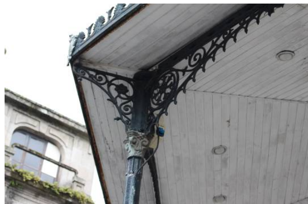
Detalle de encuentro columna, ménsulas y alero
