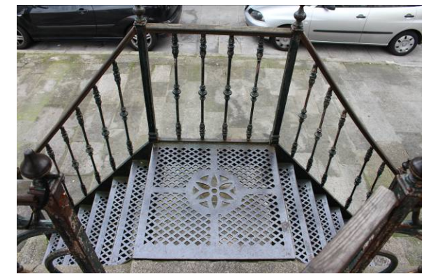
Detalle de escalera metálica
